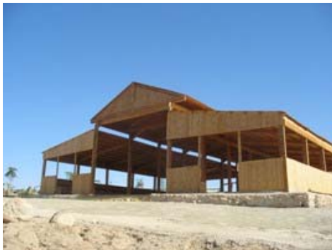
Centro de Bautismos en el Jordán
